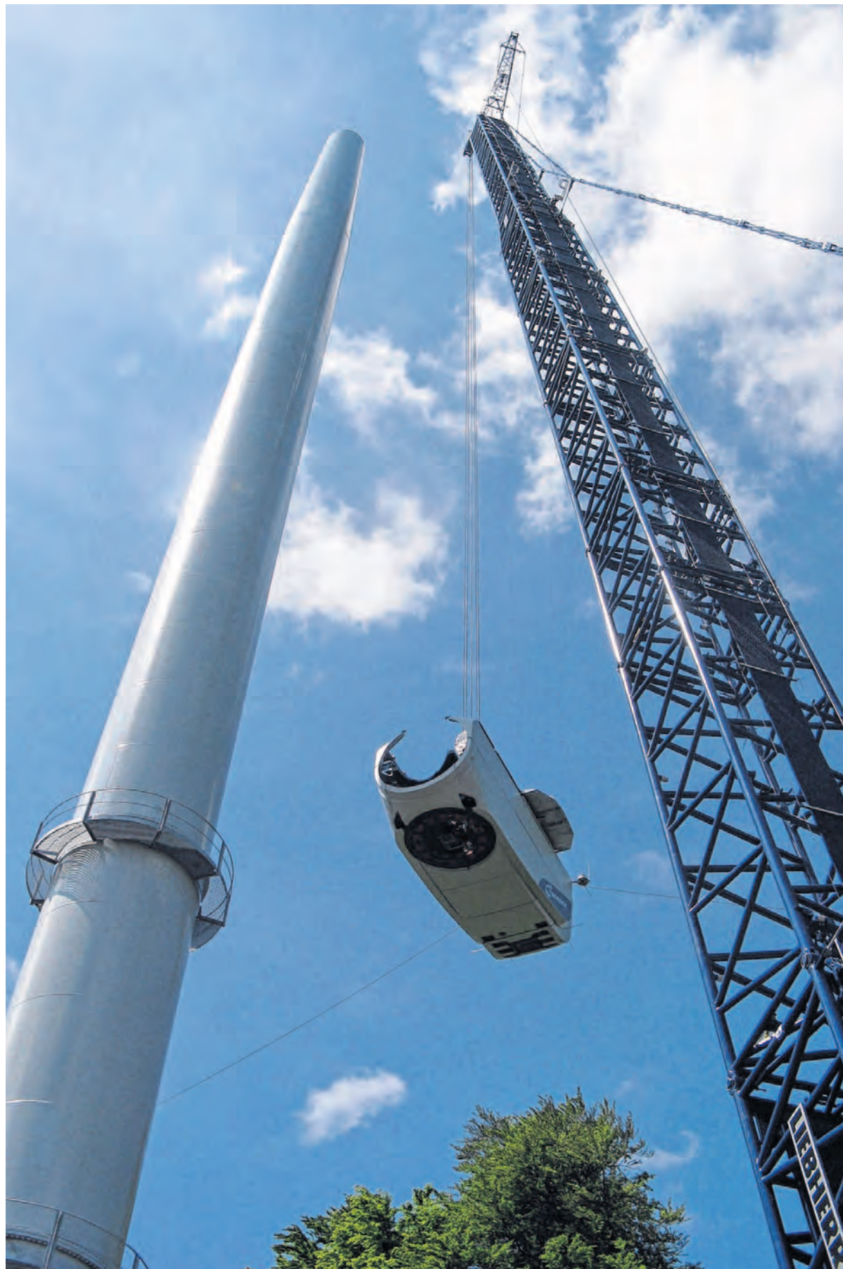
Ein hundert Meter hoher Kran hievt das Maschinenhaus auf den ebenso gewaltigen Turm der Windenergieanlage in Berschweiler. Mittlerweile sind auch die Rotorblätter montiert, so dass in wenigen Wochen der Strom fließen kann.
